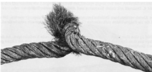
Câble métallique avec cassure
