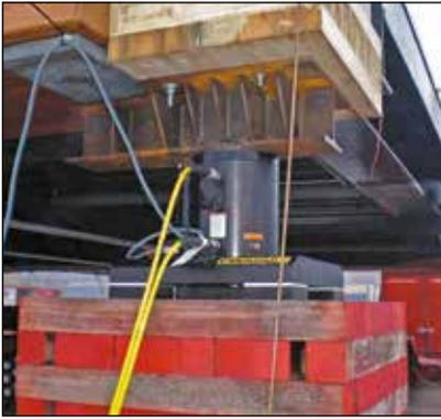
◀ Application type d'un système de levage avec vérins grimpeurs : ce système Enerpac fabriqué sur mesure soulève le pont de 360 tonnes d'Akkerwinde aux Pays-Bas.
