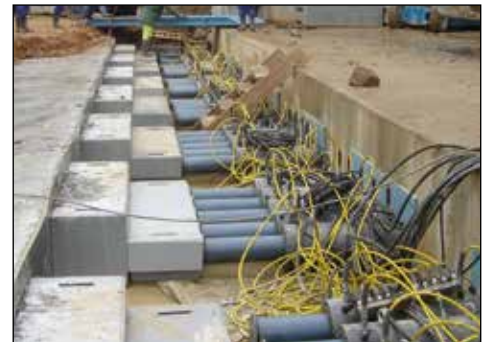
▲ Pose de caissons : Système hydraulique synchronisé multi-points utilisé pour glisser les segments de tunnel sous la voie ferrée.
