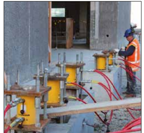
▼ Levage et mise à niveau des fondations d'une construction.
