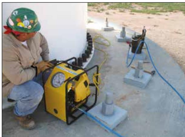
◀ *La pompe ZUTP-1500 robuste et légère est idéale pour réaliser sans effort la mise en tension de goujons dans les emplacements difficilement accessibles, en travaillant deux fois plus vite qu'avec les pompes concurrentes. Son format compact permet de l'utiliser même dans les endroits exigus.*
