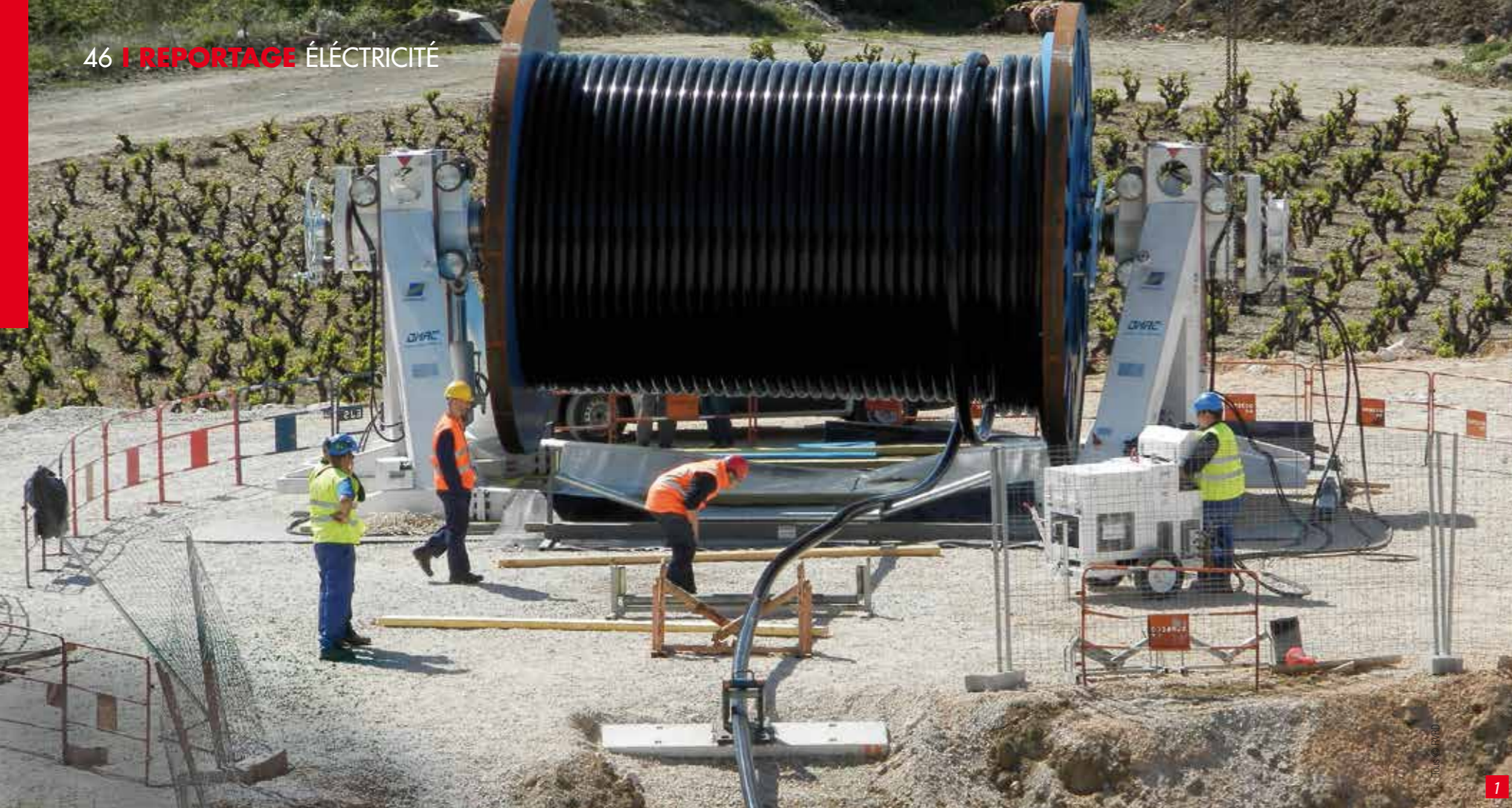
1 - C'est sur des bobines de 4,5 m de \phi et 5,5 m de large avec une masse de presque 90 t que les câbles électriques sont amenés sur le chantier. 2 - Deux treuils hydrauliques à double cabestan de 28 t et 20 t ont été mis à contribution pour ces opérations de tirage. 3 - Ce sont 2 fourreaux en PVC \phi 250 mm CR 16 qui sont mis en place pour chacune des deux liaisons.
