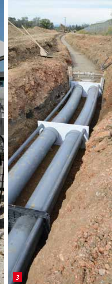
1 - C'est sur des bobines de 4,5 m de \phi et 5,5 m de large avec une masse de presque 90 t que les câbles électriques sont amenés sur le chantier. 2 - Deux treuils hydrauliques à double cabestan de 28 t et 20 t ont été mis à contribution pour ces opérations de tirage. 3 - Ce sont 2 fourreaux en PVC \phi 250 mm CR 16 qui sont mis en place pour chacune des deux liaisons.
